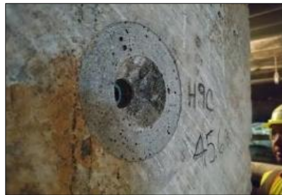
(d) Conical hole cut on Column.
