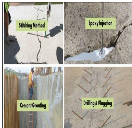
(d) Methods of crack repair.
